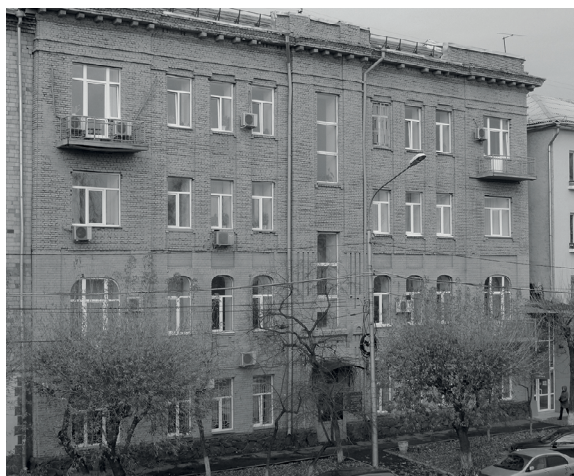
Здание Управления Министерства юстиции по Красноярскому краю, г. Красноярск, ул. Кирова, 33
