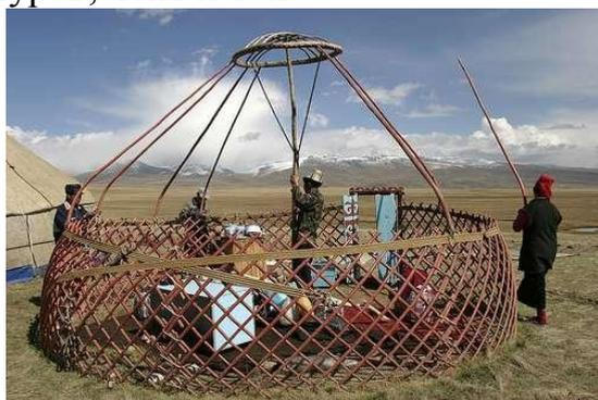
Рисунок 1. Возведение каркасной конструкции – кереге и главной святыни каждого казахского рода – обруча – шанырака.
